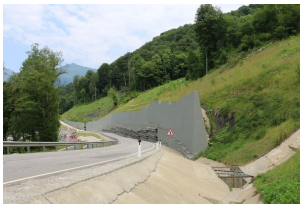
Рис. 2. Пример на фото применения данной ТСИЗ на объекте: автомобильная дорога, расположенная на склонах хребта Псехако, ведущая к горнолыжному центру ОАО Газпром
