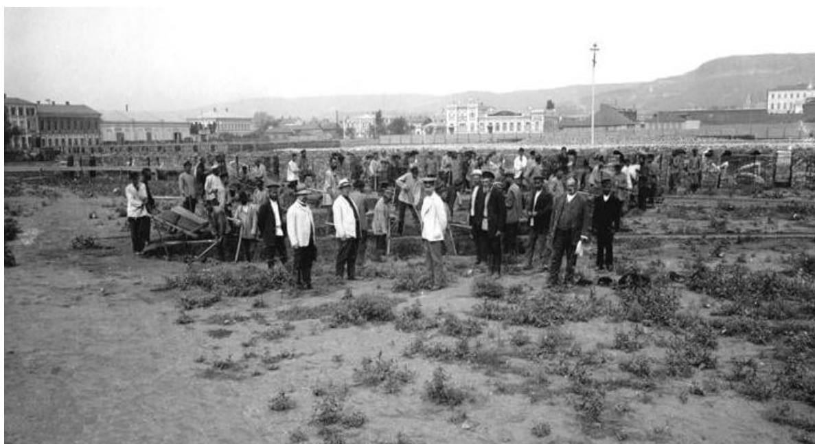
Строительство 1 корпуса СГУ
