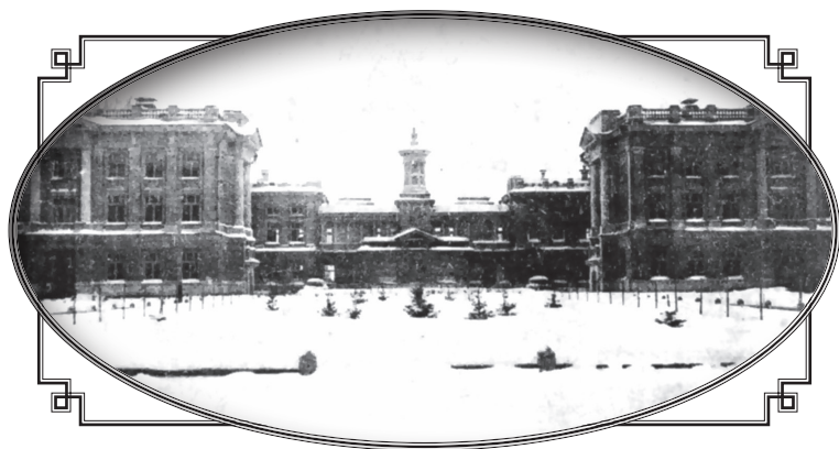
IV корпус университета, вид со двора университетского городка. Выстроен в 1913 г. Архитектор К.Л. Мюфке. 1913–1917 гг. Саратов
